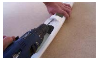
86. ...vyvrtáme otvor Ø6mm ( je vhodné si jej nejdříve předvrtat vrtákem menšího Ø) ... drill hole Ø 6 mm (we recommend drill smaller hole first).
