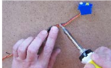
116. ...navlékneme bužírky a vše spájíme... ... insert tubes and solder together ...
